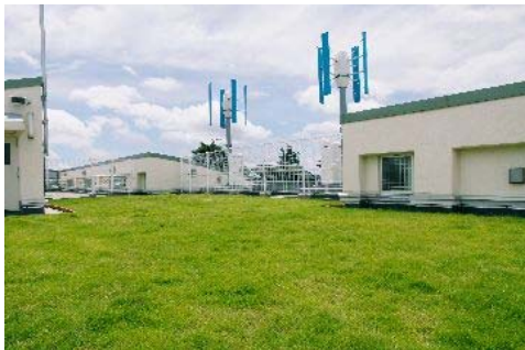
(緑野小 屋上緑化)
