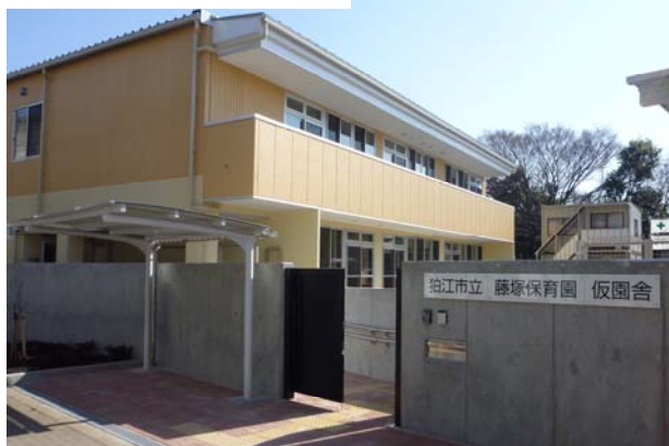
●仮園舎（東和泉1丁目）
