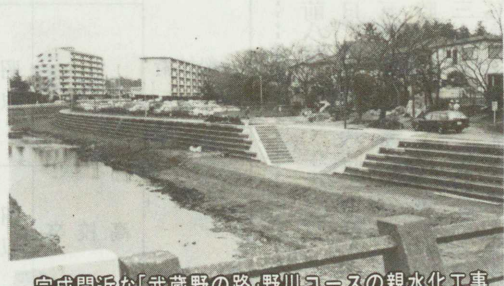
完成間近な「武蔵野の路」野川コースの親水化工事
