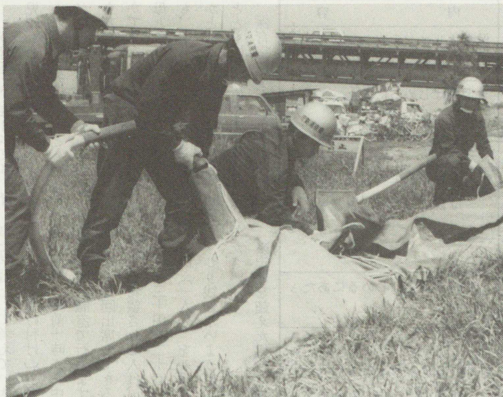
連結水のう工法(昨年の総合水防訓練)
