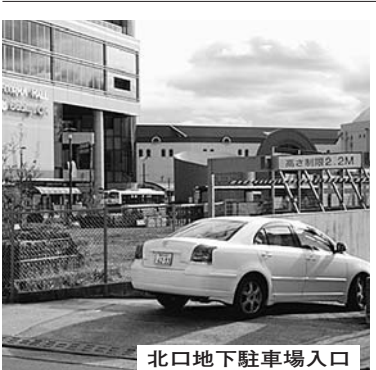
北口地下駐車場入口
