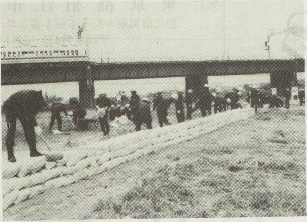
スワ増水ノに備えて土のう積み
