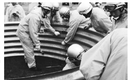
↑鋼製かまつき工法
