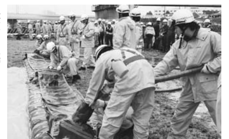
↑連結水のう工法
