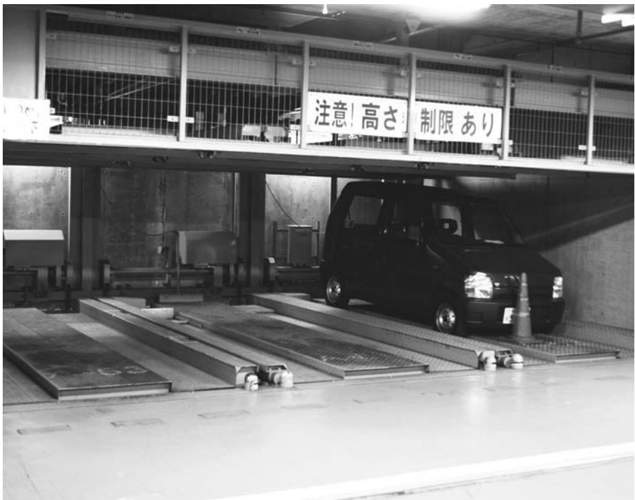
狛江駅北口地下駐車場（機械式）
