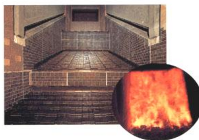
【焼却炉の内部】
