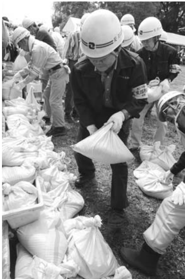
▲土のうを積んで建物内への 浸水を防ぎます
