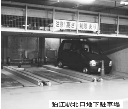
狛江駅北口地下駐車場
