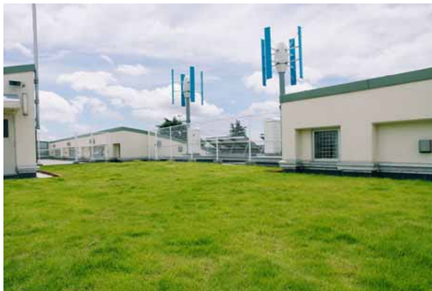
緑野小学校の屋上緑化
