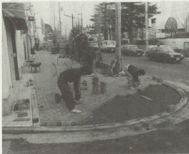
商店街道路のカラー舗装（市役所前）
