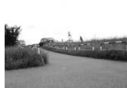
⑤ 猪方排水樋管前
