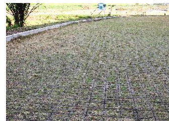
緑化舗装の例
