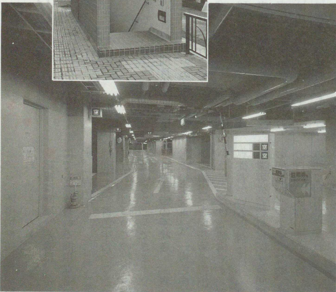
▲利用がもたれる地下駐車場
