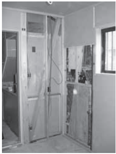
筋かいによる補強事例
