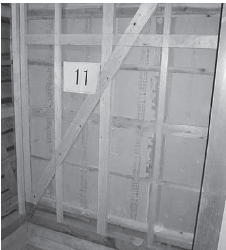
筋かいによる補強事例
